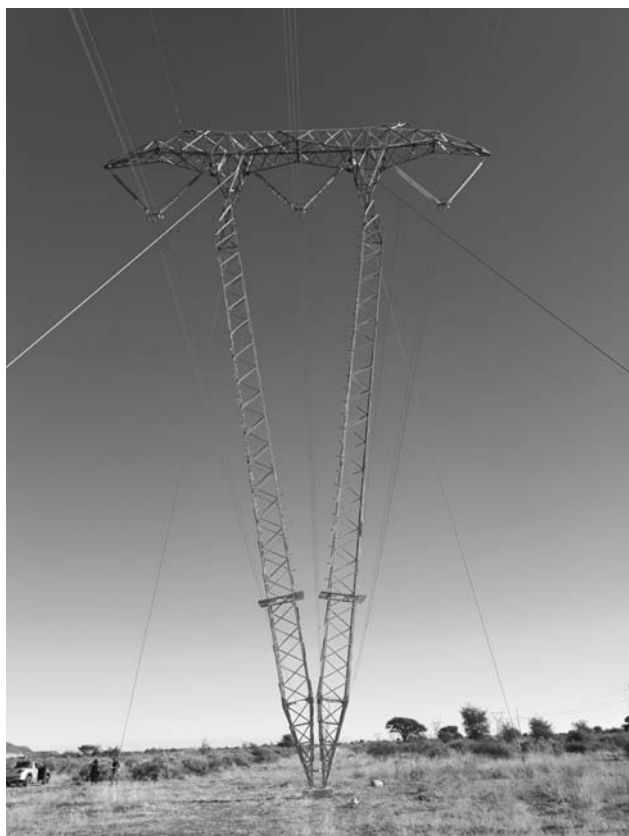
FIGUUR 1: 'n Tipe 520B kabelgesteunde V-toring.
