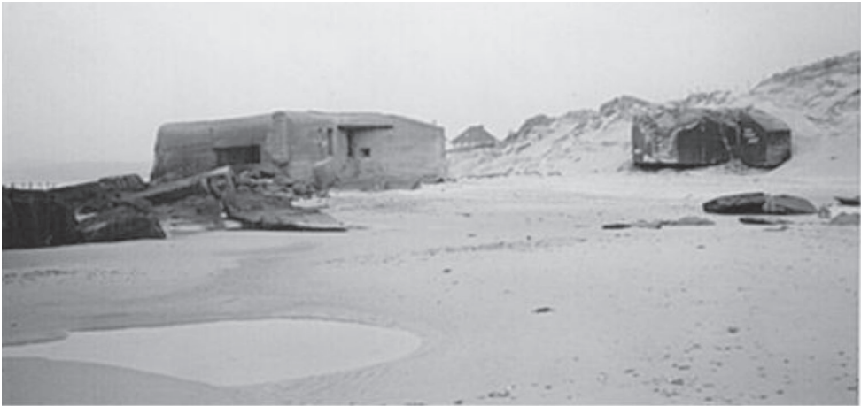
Foto 2: 'n Duitse fort wat op die strand beland het, nadat die see die duin waarop dit gebou is, vernietig het.
